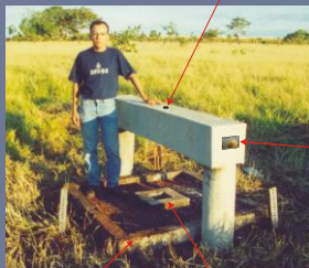
Viga de concreto com pino de centragem
